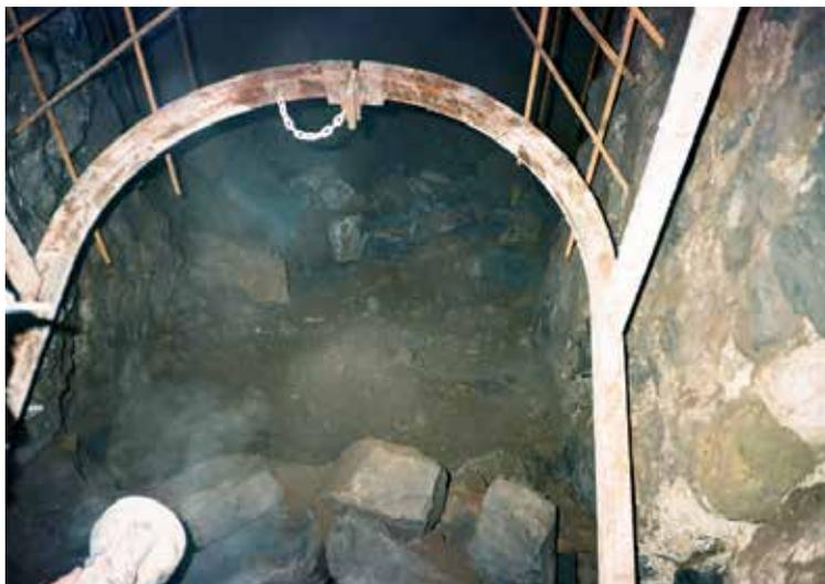
*Fig. 82 - Eliminazione di un fornello e consolidamento della sottostante volta*
