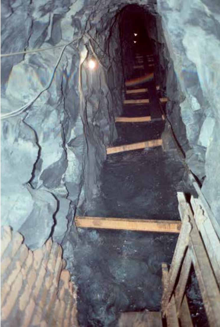
*Fig. 81 - Galleria rettificata. Notare le traversine in ferro sulle quali vengono collocati i binari visibili nella foto in basso a destra accatastati dopo la dismissione*
