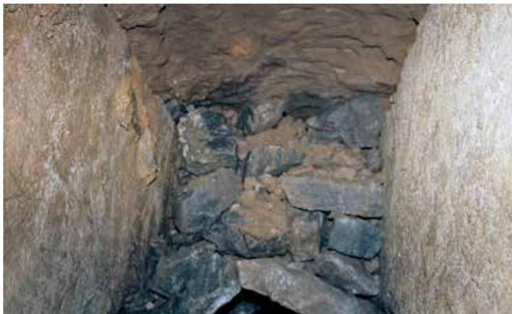
*Fig. 78 - Riempimento con materiale di risulta fra l'estradosso della volta realizzata con bolognini a forbice e la volta dello scavo*
