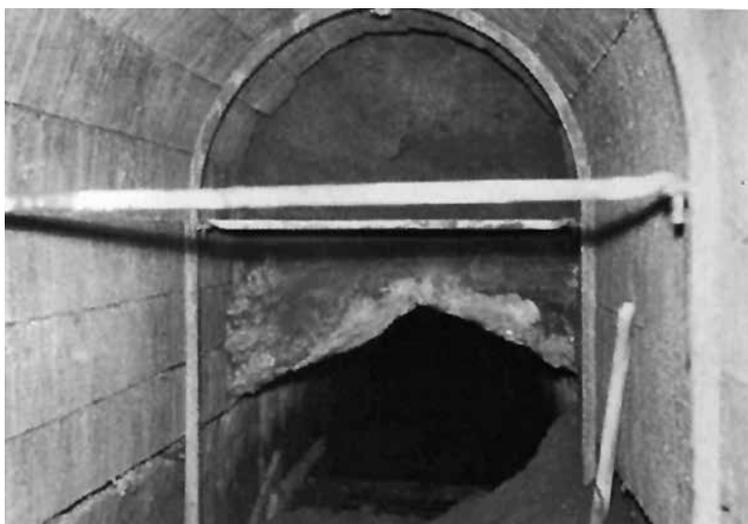
*Fig. 59 - Adeguamento della sezione della galleria Torrerosa*
