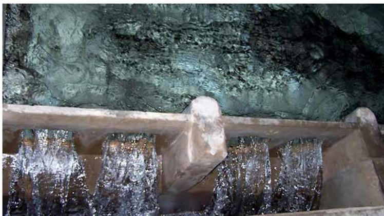
*Fig. 43 - Interno partitore Torrerossa - Particolare dei misuratori a bocca tarata dell'epoca*
