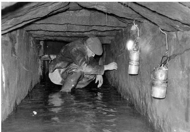
*Fig. 58 - Inadeguata altezza della galleria Torrerosa prima del suo ampliamento. Appollaiato l'acquiolo Michele Garozzo*
