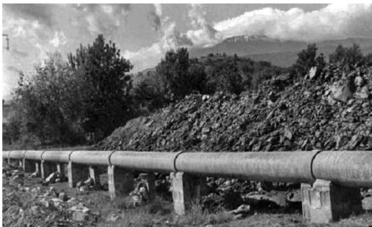
*Fig. 55 - Sostituzione acquedotto Marauli con tubi di mm. 500*
