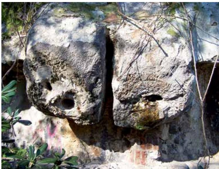
*Fig. 53 - Condotte di scarico dell'acqua nella "cammara da rota"*
